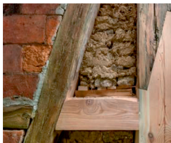
Fachwerkstiele wurden ersetzt [1] Blick auf hintere Lehmsteinziegelwand
